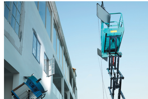
Использование низкорасположенных мощных осветительных приборов
